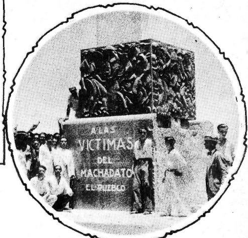
BORRANDO HUELLAS DE LA DICTADURA .—La farola de la calle 23, dedicada por el pueblo a las víctimas del Machadato, después de
